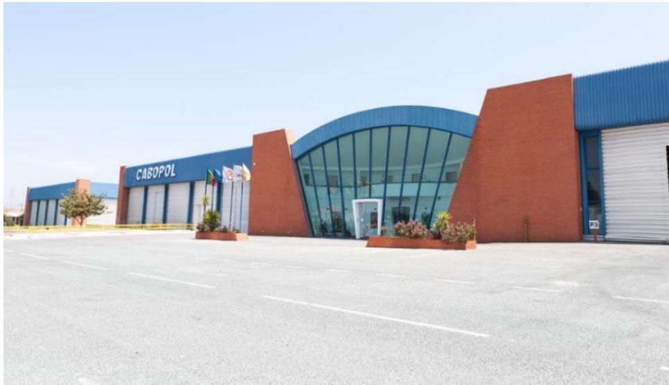
Figura 2.2 – Instalações da Cabopol 1.
